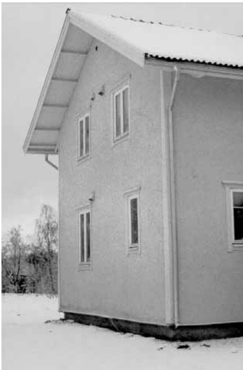
Figur 3.4 Lerputsad halmbalsvägg - Storkeboda.
