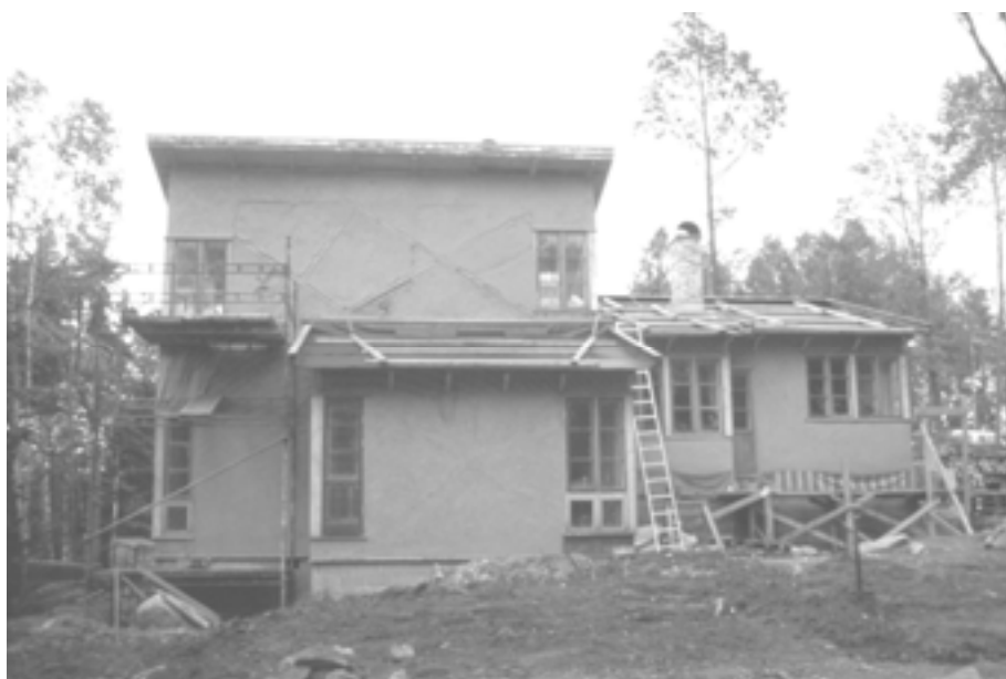
Figur 2.12 och 2.13 Familjen Wallners hus under byggtiden
