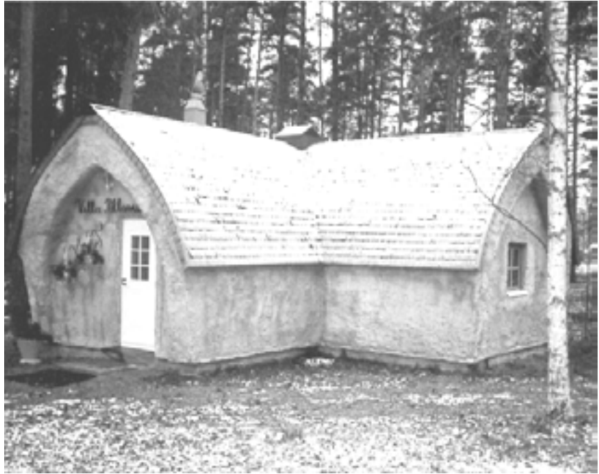
Figur 2.9 Finskt halmbygge med spåntak
