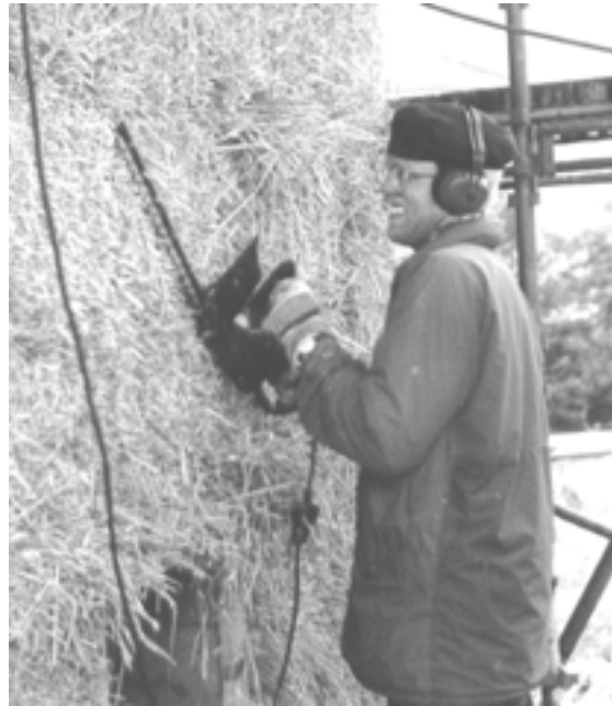
Figur 5.16 Trimning av halmbalsväggen
