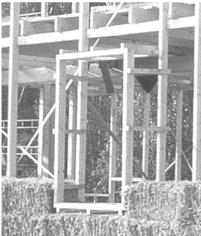
Figur 5.4 Konstruktion för montering av fönster.
