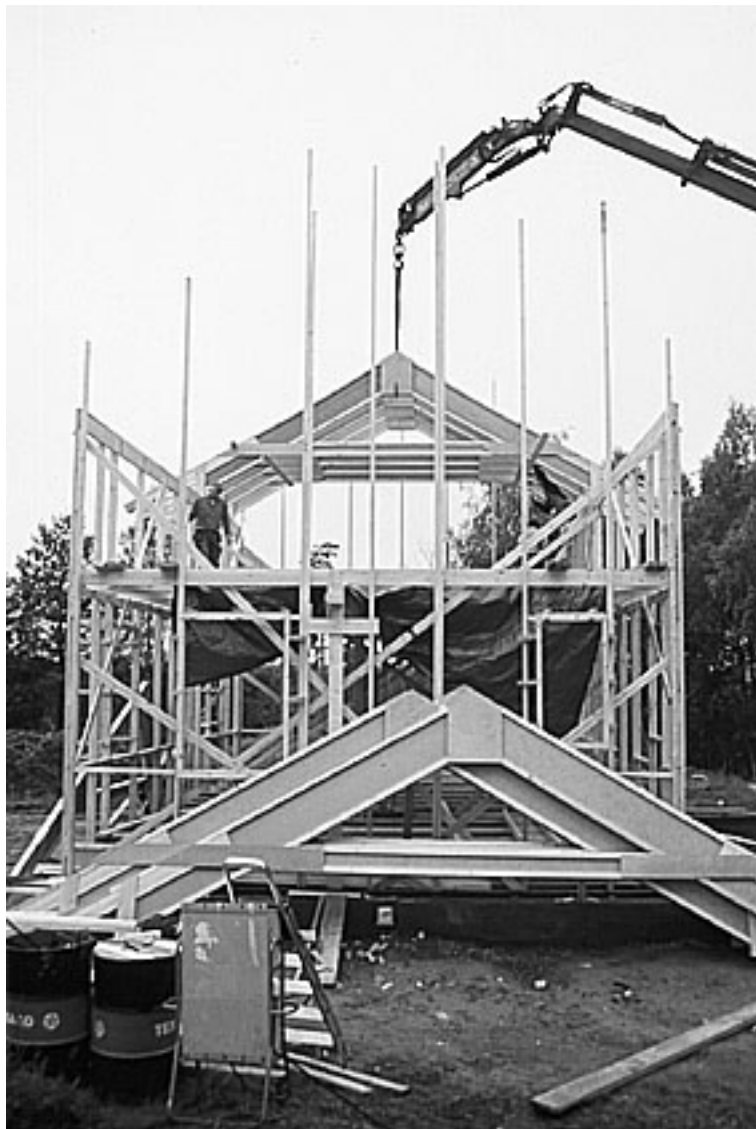
Figur 5.3 Montering av takstolar
