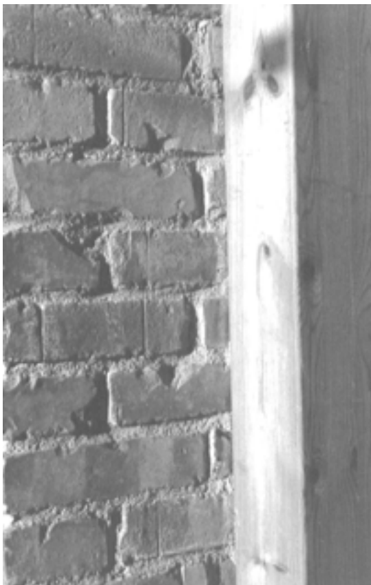
Figur 5.14 Mellanväggar i våtrum av återanvänt tegel
