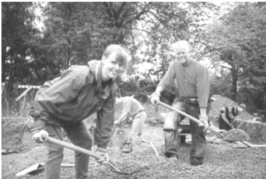
Figur 5.2 Sara Norrby Wallin och Pär Wallin lägger grunden till sitt framtida hem.
