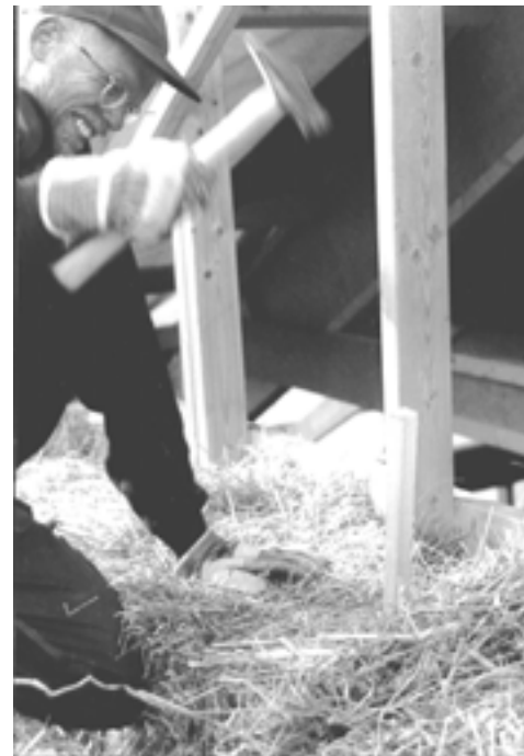
Figur 5.11 Två dymlingar i varje bal
