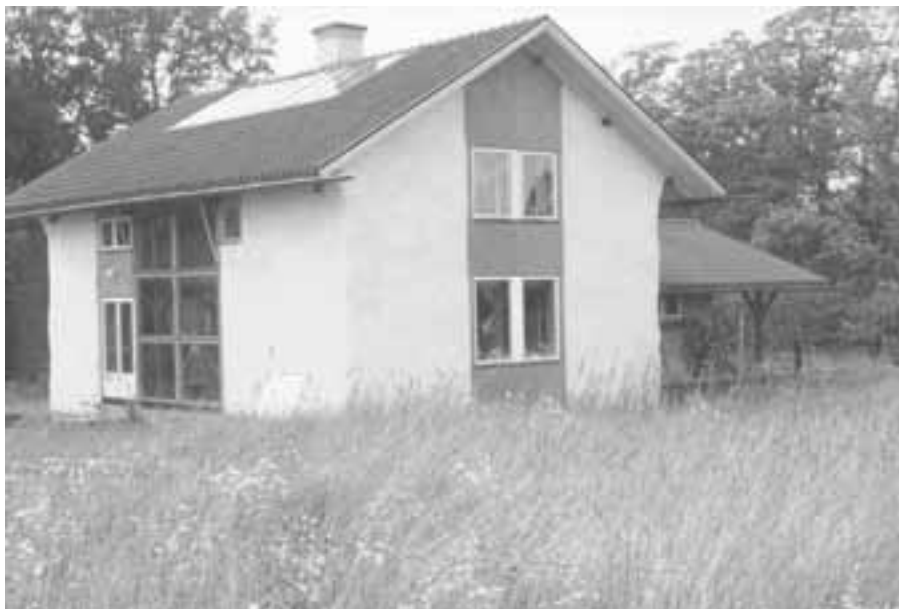
Figur 2.10 Halmbalshus vid Skäve gård i utanför Järna byggt 1996. Våtrumsdelen till höger byggt i lättklinker.
